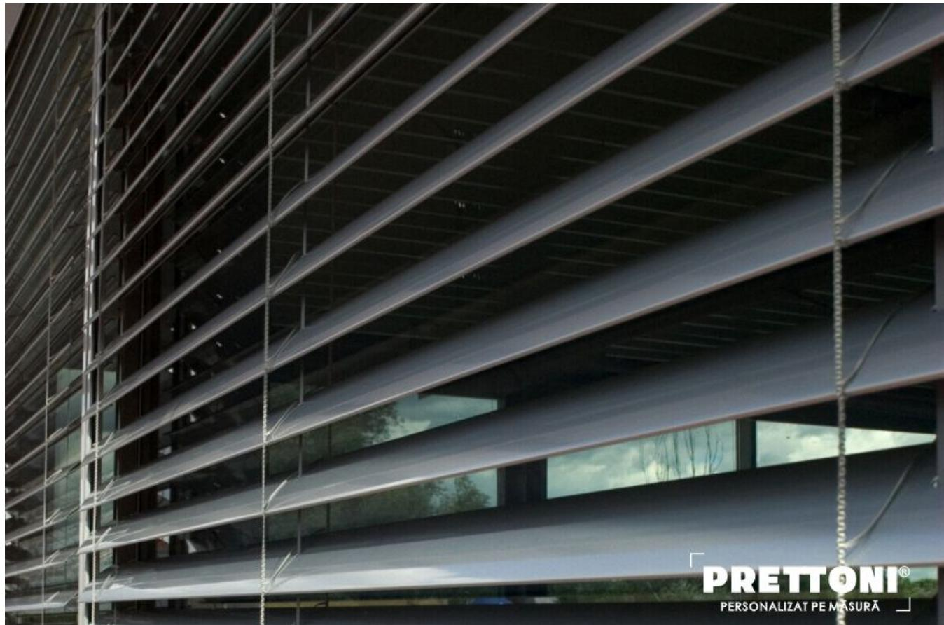
Atunci când se utilizează **jaluzele orizontale exterioare motorizate**, nu există o manivelă introdusă în casă, acționarea se realizează cu ajutorul unui motor electric, care nu mărește dimensiunea jaluzelelor și nu le face mai zgomotoase.
